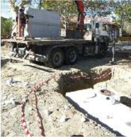
Pose de la cuve servant de local technique où seront installés l'électricité, la plomberie, la pompe et tout le nécessaire pour le fonctionnement de la fontaine
