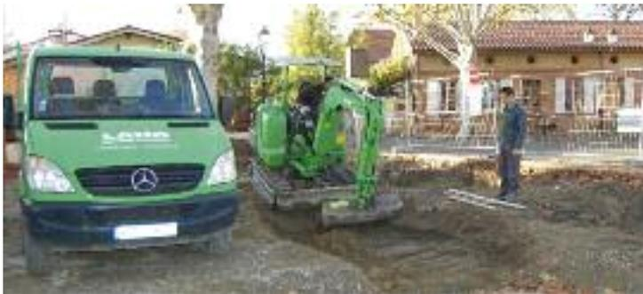
Décaissage et évacuation de la terre aux emplacements prévus par le concepteur pour l'implantation des blocs de la fontaine
