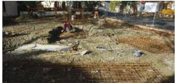
Ferraillage des assises de béton sur lesquelles reposeront les blocs de granit et les caniveaux qui composeront la fontaine
