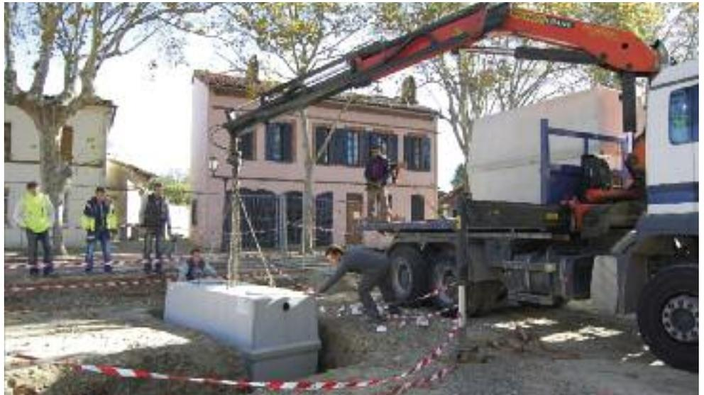
Mise en place de la cuve de 6 000 litres destinée à contenir l'eau que sera utilisée en circuit fermée pour la fontaine
